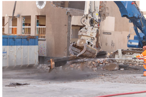
Abbildung 17: Rückgebautes Holzelement (Schulgebäude) wird mit Wasser besprüht, um die Staubbildung zu minimieren (Foto L. Seidl, BFH)
