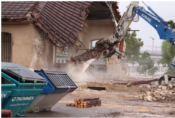
Abbildung 16: Rückbau der Schulanlage (Turnhalle) Triemli in Zürich mit einem Bagger (Foto L. Seidl, BFH).
