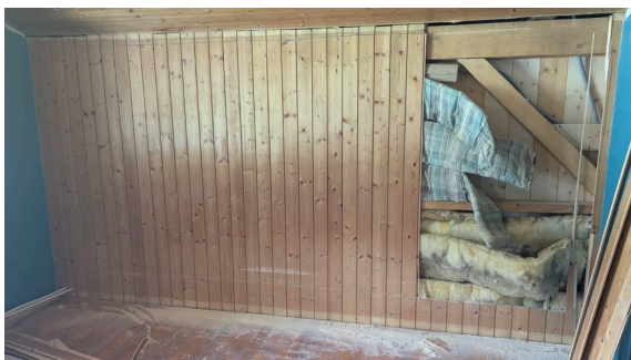
Abbildung 26: Rückbau der Innen-Holzverkleidung mit einem Trennschnitt oben und unten (Foto M. Arnold, OLWO).
