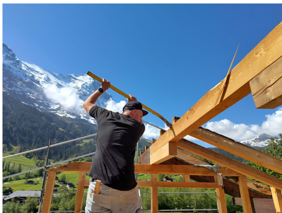
Abbildung 38: heraushebeln der Sparren mit einem Brecheisen (Foto P. Fuchs, BFH)
