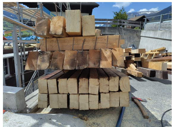
Abbildung 39: rückgebautes Altholz aus dem Dachstuhl mit Sparren-Nägeln (Foto P. Fuchs, BFH)
