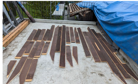
Abbildung 35: Rückgebaute Aussen-Holzverkleidung (Foto M. Arnold, OLWO)
