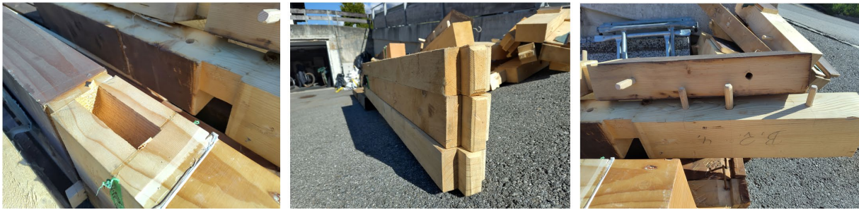
Abbildung 40: Holzverbindungen beim Rückgebauten Altholz aus der Wand. (Fotos P. Fuchs, BFH)
