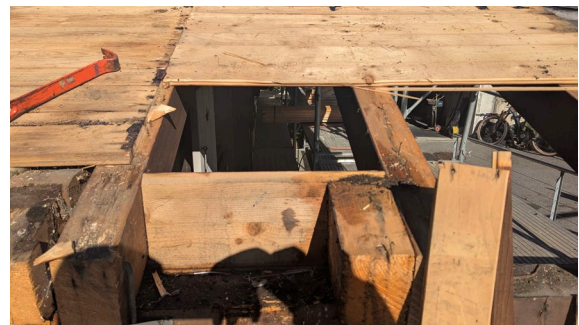
Abbildung 37: Rückbau der genagelten Unterdachbretter mit einem Brecheisen (Foto M. Arnold, OLWO)
