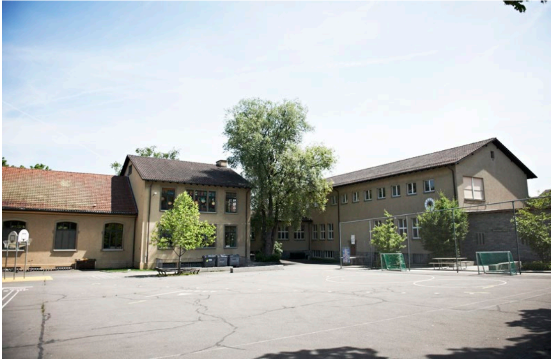
Abbildung 8: Schulanlage Triemli in Zürich vor dem Rückbau der Turnhalle (links) und dem Schulgebäude mit Klassenzimmern (rechts, Bild: Stadt Zürich)
