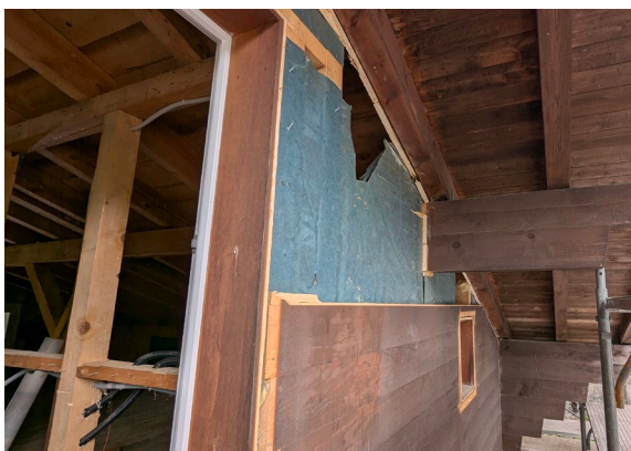
Abbildung 32: Rückbau der Aussen-Holzverkleidung (Foto M. Arnold, OLWO)
