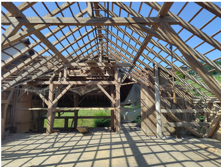
Abbildung 21: Landwirtschaftliches Holzgebäude nach dem Rückbau der Ziegel (Foto P. Fuchs, BFH)
