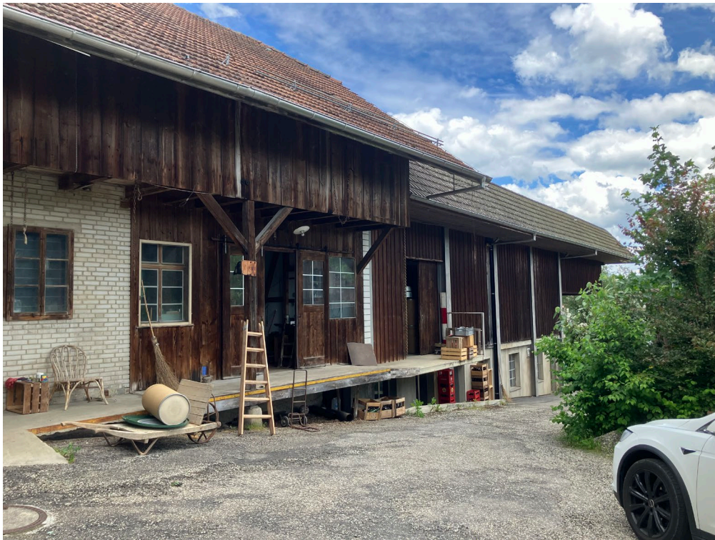
Abbildung 9: Landwirtschaftliches Holzgebäude in Vordemwald vor dem Rückbau (Foto C. Fluri)
