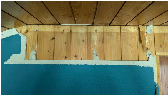
Abbildung 28: Erschwerter Rückbau der beplankten Holzverkleidungen mit Gipsfaserplatten (Foto. M. Arnold, OLWO).
