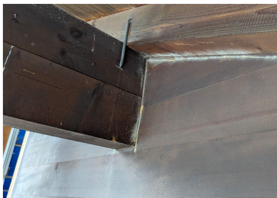
Abbildung 33: Erschwerter Rückbau der Aussen-Holzverkleidung durch die teils eingenetete oder von innen befestigte Aussenverkleidung (Foto M. Arnold, OLWO)
