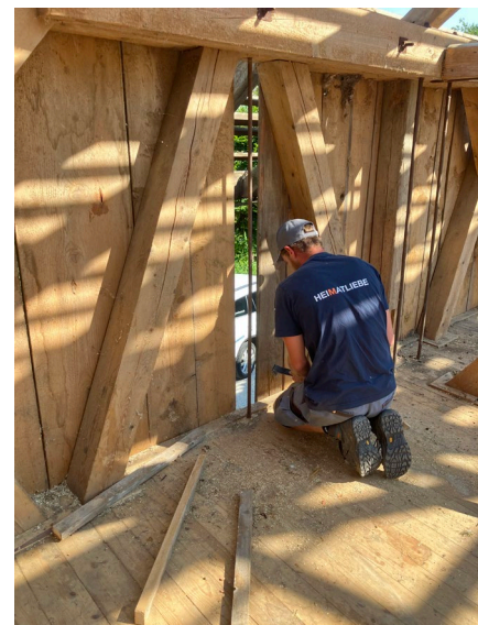
Abbildung 22: Rückbau der Aussen-Holzverkleidungen mit einem Brecheisen (Foto C. Fluri).
