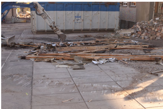
Abbildung 18: Separierte Holzbalken werden mit einem Minibagger von den Dachlatten befreit (Foto L. Seidl, BFH).
