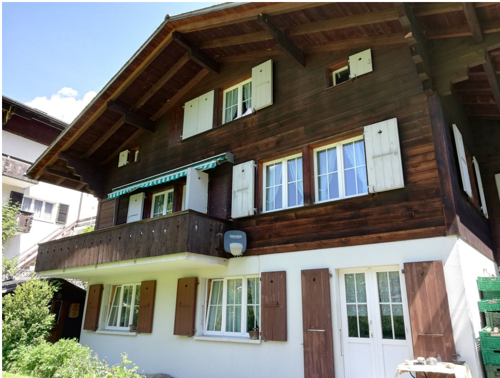
Abbildung 10: Einfamilienhaus aus Holz in Grindelwald vor dem Rückbau (Foto L. Seidl, BFH)
