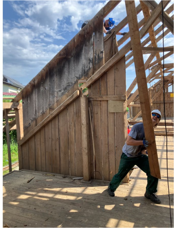
Abbildung 23: Abtrennen der Sparren mit einer Kettensäge unten und oben (Foto links) und Abdrehen des Sparrens auf der Mittelpfette (Foto rechts, Fotos C. Fluri).
